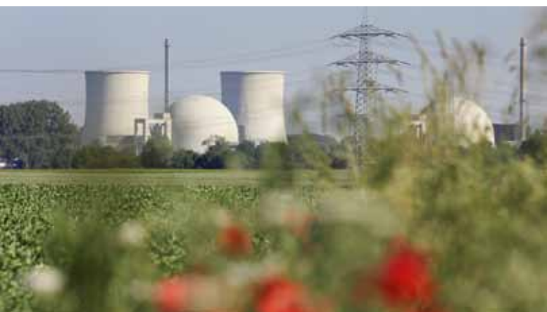
Zwei von sieben Meilern, die derzeit unter einem Moratorium stehen: Kernkraftwerk Biblis, Blöcke A und B. Foto: RWE
